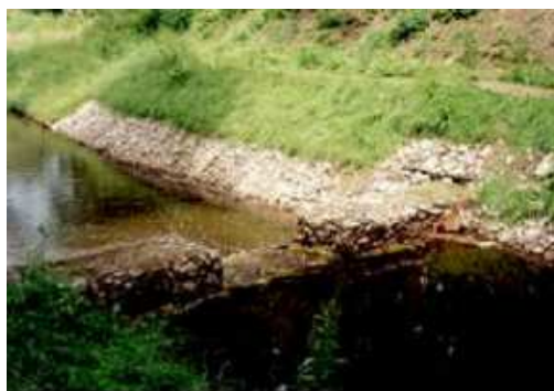
Fot. 5.8. Stopień wykonany z kamieni wtopionych w beton i próg z elementów siatkowo-kamiennych
