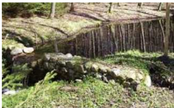
Fot. 5.8. Stopień wykonany z kamieni wtopionych w beton i próg z elementów siatkowo-kamiennych
