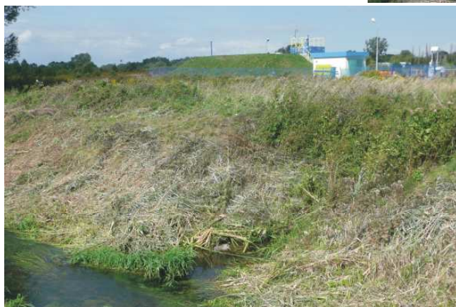
Fot. 7.3. Największa oczyszczalnia ścieków na terenie powiatu pruszkowskiego w Pruszkowie, M. Fic, 2007.
