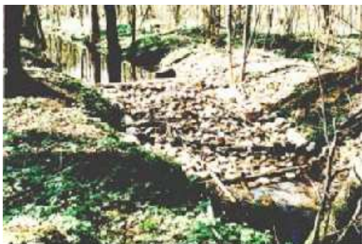
Fot. 5.10. Bystrotok wykonany z narzutu kamiennego w płotkach (Puszcza Białowieska) oraz z elementów gabionowych (rzeka Skrwa)
