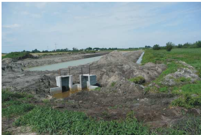
Fot. 7.2. Aktualnie wykonane stawy osadnikowe podczyszczające wody spustowe ze stawów do Raszynki, M. Fic, 2007.
