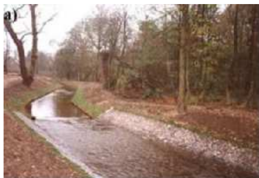
Fot. 5.10. Bystrotok wykonany z narzutu kamiennego w płotkach (Puszcza Białowieska) oraz z elementów gabionowych (rzeka Skrwa)
