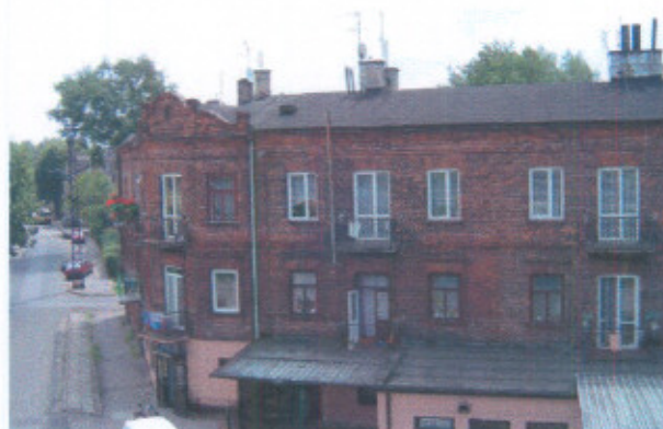
Rys. 24. Otoczenie stacji pomiarowej w Pruszkowie. ul.Majowa 14. w kierunkach północnym, zachodnim, wschodnim i południowym
